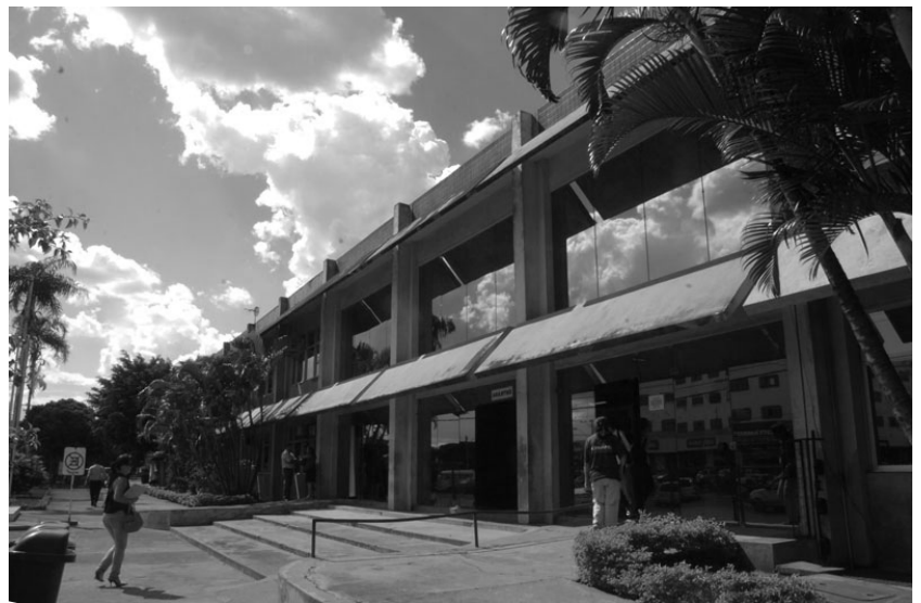
Acima, Fachada do Fórum de Ceilândia e Cerimônia de sua inauguração. Abaixo, Portaria que instalou as primeiras varas da Circunscrição Judiciária de Ceilândia.
