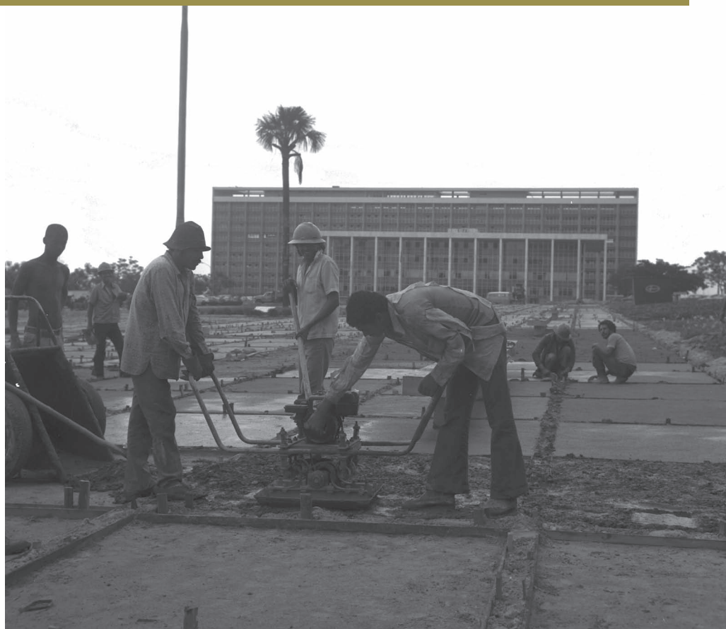
Operários da construção civil trabalham na Praça do Buriti, em frente ao Tribunal de Justiça do Distrito Federal e dos Territórios.
