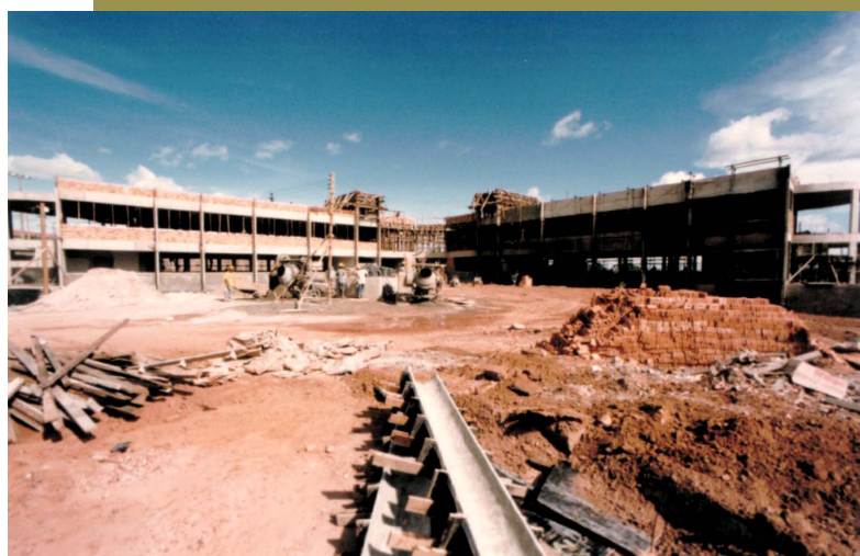
Obras de construção do Fórum do Paranoá.
